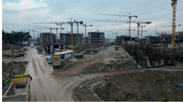
25c. İnşaat Süreci
