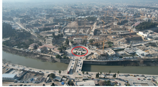
24c. İnşaat Süreci
