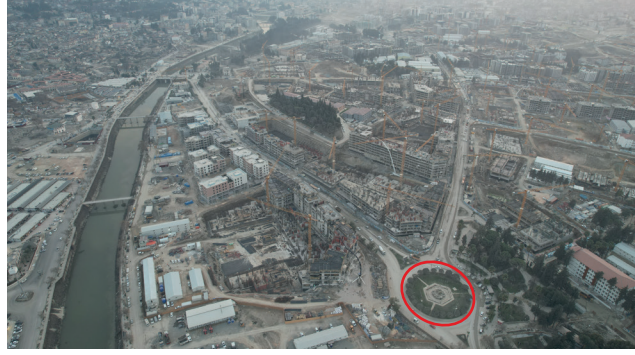
23c. İnşaat Süreci
